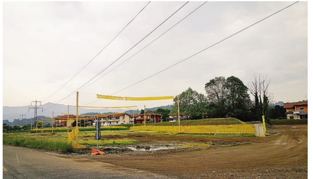
Il cantiere della Treviolo-Paladina, per il tratto successivo fino a Villa d'Almè non ci sono i fondi
