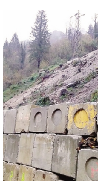
Il muro di contenimento
